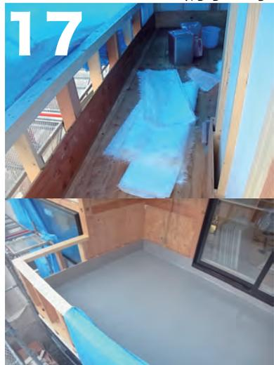
ベランダがある場合、屋根材取付けなどの作業と並行して、ベランダ部分も防水工事を施します。ベランダの防水工事に不具合があると、1階屋根部分に雨漏りが発生する可能性が高くなりますので、慎重に工事を行う必要があります。
