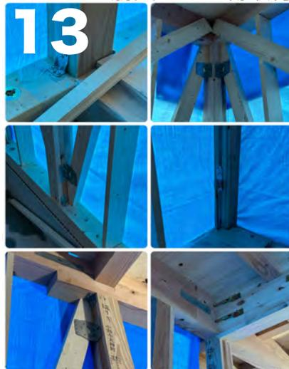
柱や梁、筋交いなどに構造金物を取り付けます。構造金物とは、木材の接合等の補強等のために用いる金物で、接合金物とも呼ばれており、使用する箇所によって金物の種類の使い分けがあります。
