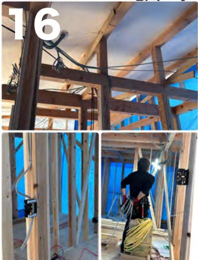
電気ケーブルなどの配線は見た目スッキリするように、「壁」や「天井」の中に隠す。隠ぺい配線を行っています。電気工事の職人さんが2～3日かけて施工するのが一般的です。この配線工事と同じ時期に、壁の中に隠れるように「スイッチBOX」や「コンセントBOX」「給排気口のジャバラ管」などの仕込みも済ませてしまいます。
