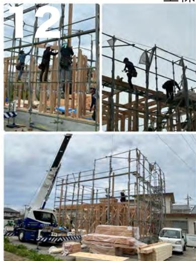
上棟とは、主に木造住宅の建築において、柱や梁などの基本構造が完成した後に、屋根の一番上の部材である「棟木」と呼ばれる木材を取り付けることです。「棟上げ」「建方」「建前」という言い方もされます。当日は5～6人の大工さんとレッカーに屋根屋さんも来ます。
