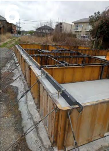
設計図に沿って型枠を組み立てていきます。
