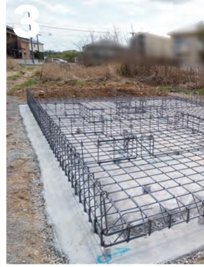
基礎配筋とは、基礎の鉄筋部分を組む工程のことです。
